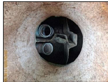
บ่อกักน้ำก่อนเข้าระบบบำบัดน้ำเสียของอาคารที่ทำการดับเพลิงและหน่วยกู้ภัยทางด้านซ้ายมือ
