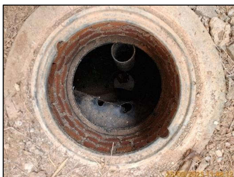
บ่อฟักน้ำหลังผ่านระบบบำบัดน้ำเสียของอาคารผู้โดยสารขาออก ชุดที่ 2
