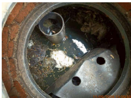
บ่อกักน้ำก่อนเข้าระบบบำบัดน้ำเสียของอาคารผู้โดยสารขาออก ชุดที่ 2
