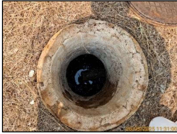
บ่อกักน้ำก่อนเข้าระบบบำบัดน้ำเสียของอาคารทำการดับเพลิงและหน่วยกู้ภัยทางด้านขวามือ
