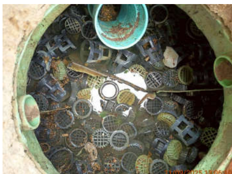
บ่อกักน้ำก่อนเข้าระบบบำบัดน้ำเสียของอาคารหอบังคับการบิน
