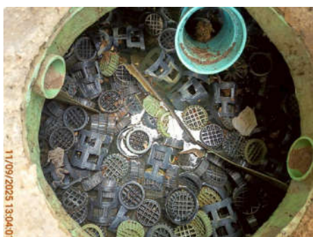
บ่อกักน้ำหลังผ่านระบบบำบัดน้ำเสียของอาคารหอบังคับการบิน
