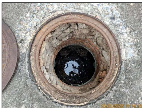
บ่อฟักน้ำก่อนเข้าระบบบำบัดน้ำเสียของอาคารผู้โดยสารขาออก ชุดที่ 1
