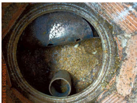
บ่อกักน้ำก่อนเข้าระบบบำบัดน้ำเสียของอาคารผู้โดยสารขาออก ชุดที่ 3
