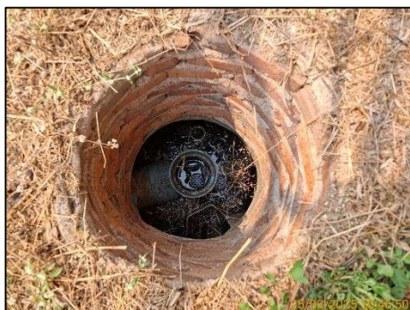
บ่อกักน้ำก่อนเข้าระบบบำบัดน้ำเสียของอาคารผู้โดยสารขาเข้า ชุดที่ 1
