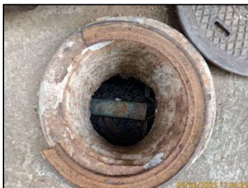
บ่อกักน้ำหลังผ่านระบบบำบัดน้ำเสียของอาคารที่ทำการดับเพลิงและหน่วยกู้ภัยทางด้านซ้ายมือ
