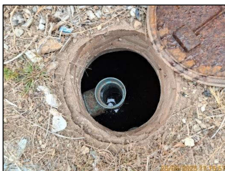
บ่อฟักน้ำหลังผ่านระบบบำบัดน้ำเสียของอาคารผู้โดยสารขาออก ชุดที่ 1
