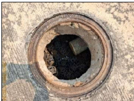
บ่อกักน้ำก่อนเข้าระบบบำบัดน้ำเสียของอาคารผู้โดยสารขาเข้า ชุดที่ 3
