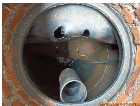
บ่อกักน้ำหลังผ่านระบบบำบัดน้ำเสียของอาคารผู้โดยสารขาออก ชุดที่ 2
