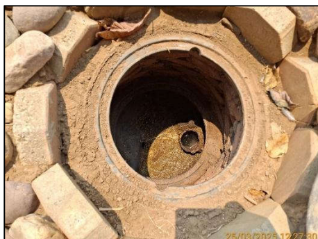
บ่อกักน้ำก่อนเข้าระบบบำบัดน้ำเสียของอาคารผู้โดยสารขาเข้า ชุดที่ 4
